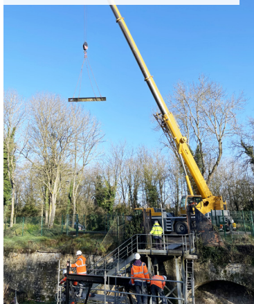
Grutage et mise en place des poutrelles longitudinales du tablier.
