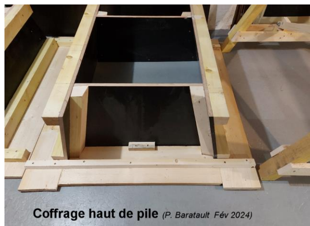
Coupes des coffrages des piles
