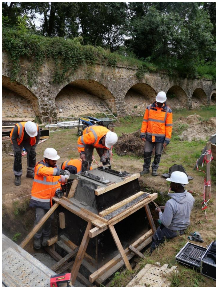
Coffrage et coulée du béton
