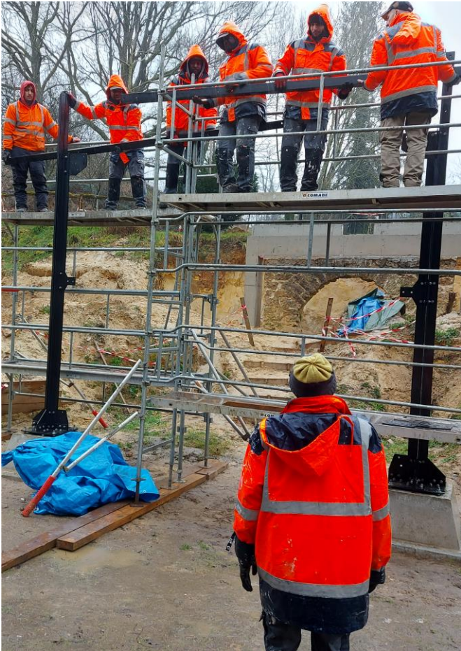
Mise en place du portique central sous la pluie
