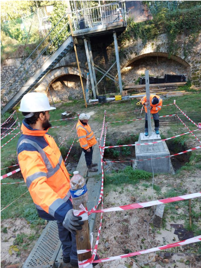
Références de niveau (Pedro en action avec niveau à eau)
