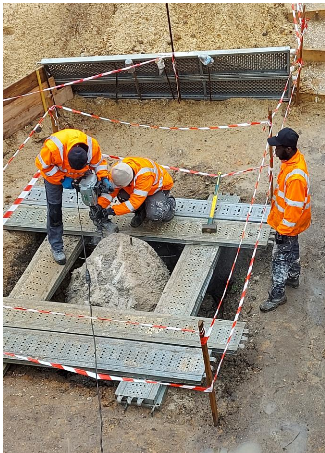
Dégagement d'une pile au marteau piqueur
