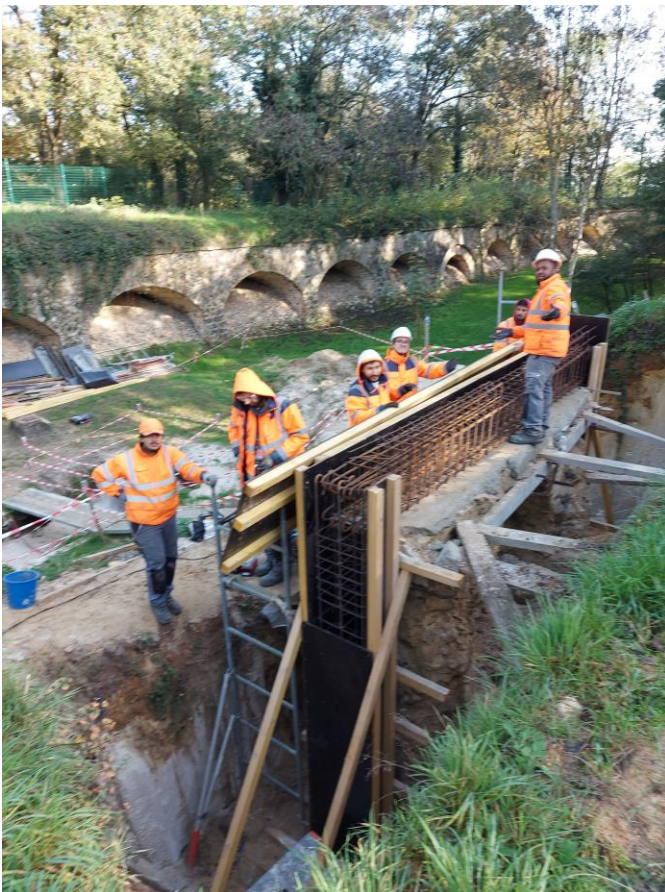
Ferrailage culée côté cour
