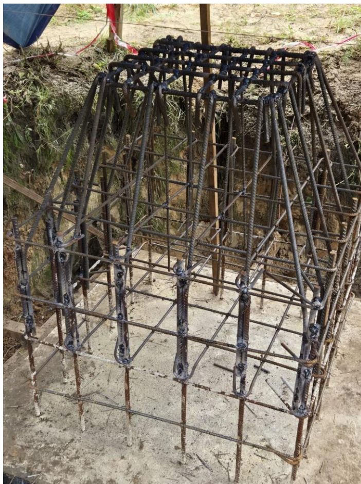
Ferrailles d'une pile
