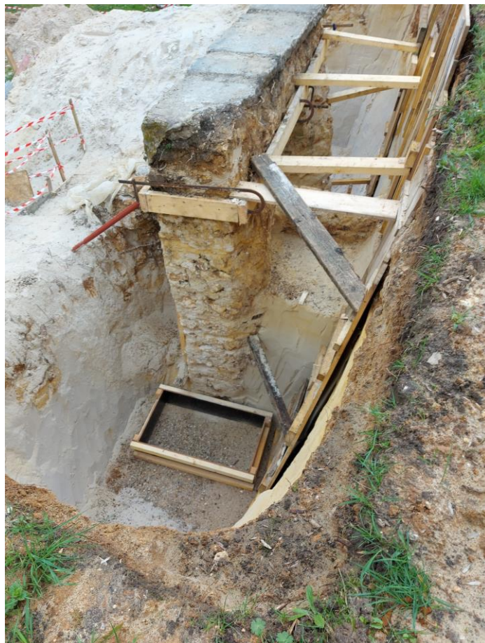
Une couche de propreté en place au pied de la culée
