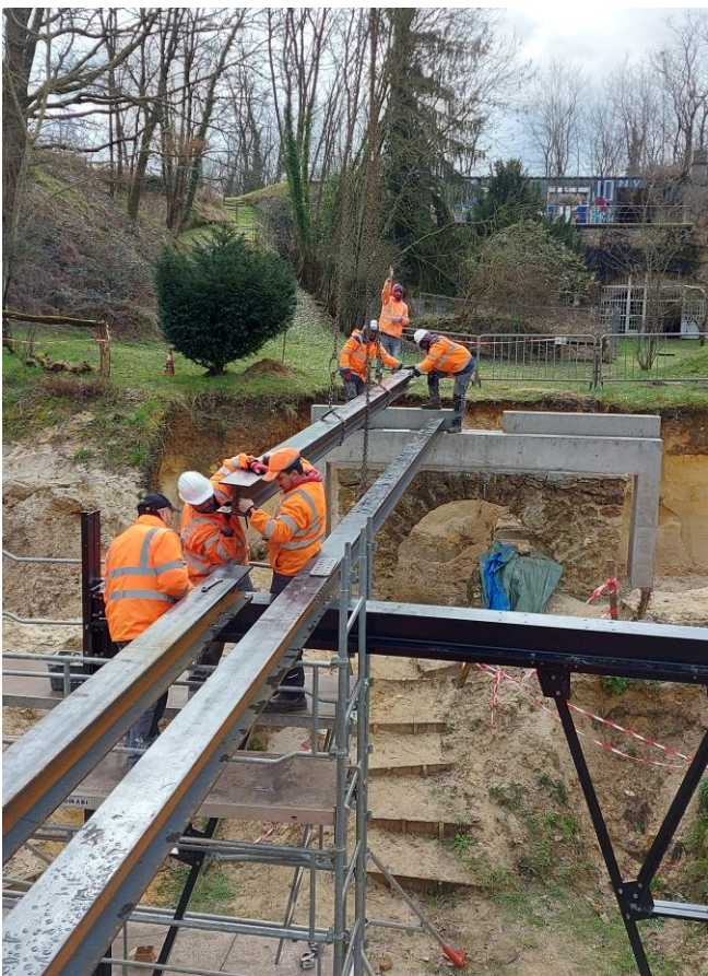
Mise en place des poutres longitudinales avec grutier
