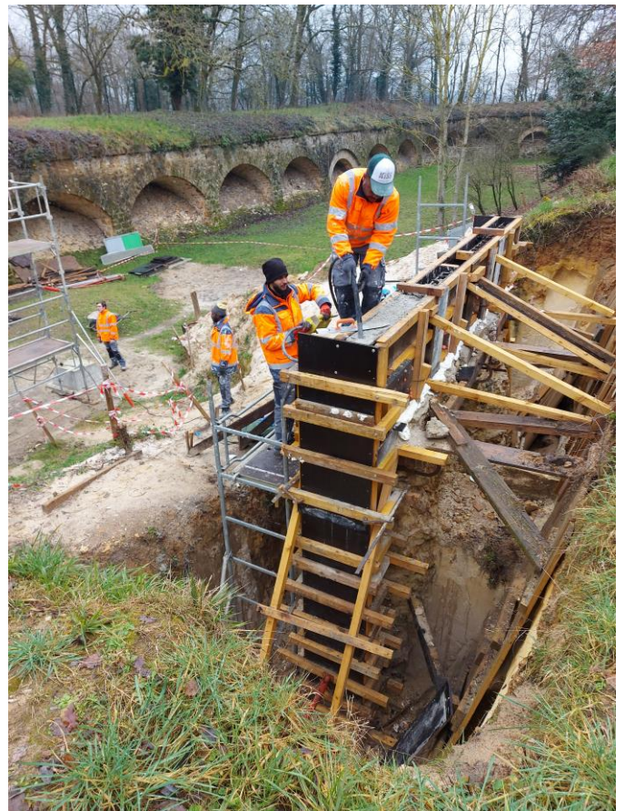
Coulée et vibration du béton
