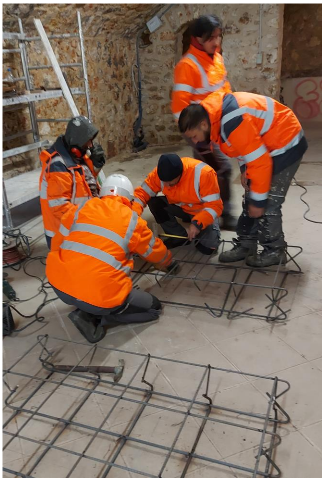
Préparation des ferrailles en atelier
