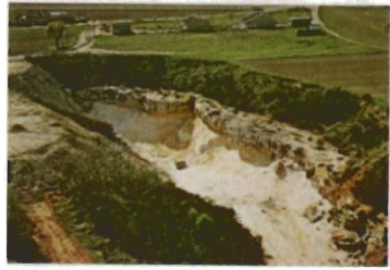
Figure 3 : Carrière de sable et grès à Villejust
